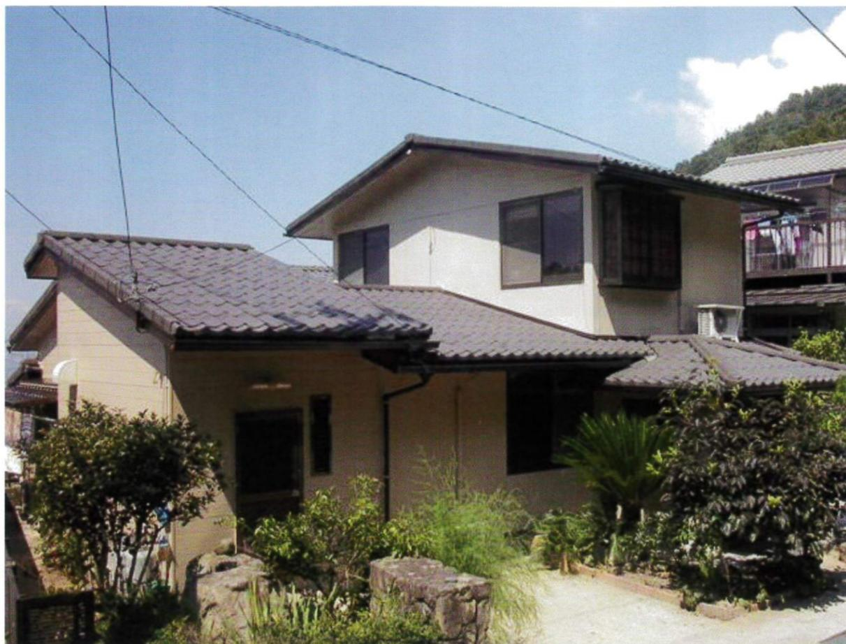
積水化学「かわらU」の傷んだ屋根に「ファイバー Jacket」を施工
