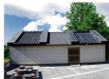
小屋裏温度実験棟
